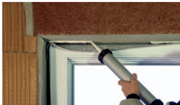
Anwendungsbeispiel: ISO 3 -FENSTERDICHTSYSTEM
